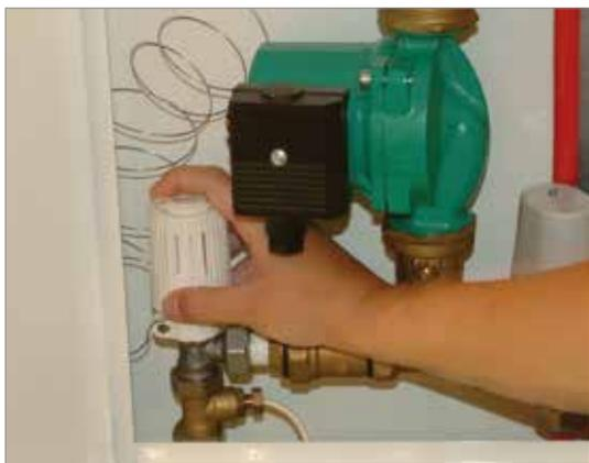
Температура подачи коллекторного узла определяется позицией термостатической головки R462L в соответствии с приведенной ниже таблицей. Точность регулировки очень высокая (около  $\pm 1^\circ\text{C}$ ), поэтому рекомендуется проводить настройку при режимной работе установки. Для избежания возможного произвольного смещения проведённой корректировки, можно зафиксировать головку при помощи соответствующего металлического стопора.
