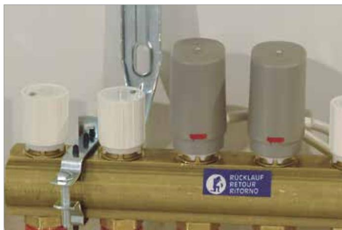
Электротермические сервоприводы, установленные на коллектор.
