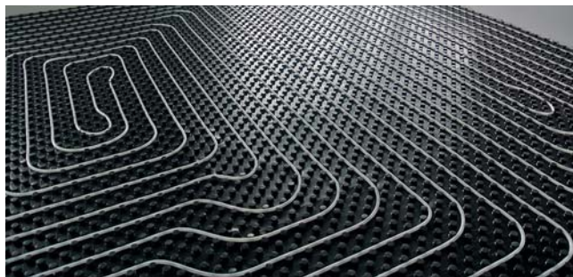
Рисунок 9: Укладка труб для теплого пола
